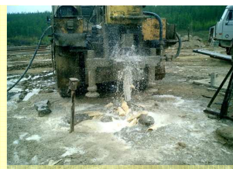
Разбуривание зоны скважины с криогелем
